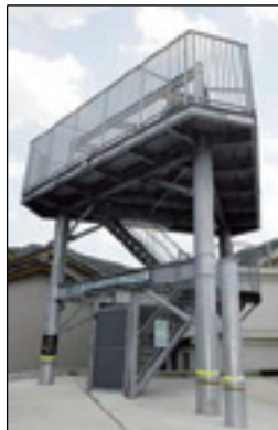
津波避難タワー
