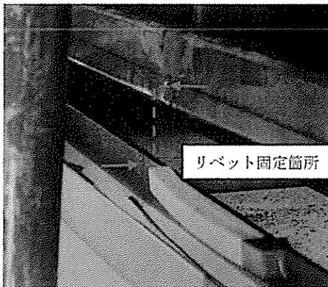
図 2-2 骨組み留め付けリベット抜け状況
