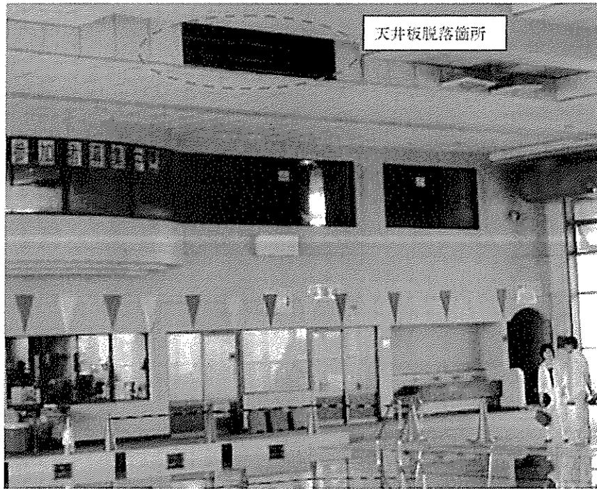
図 2-1 天井立ち上がり部脱落状況
