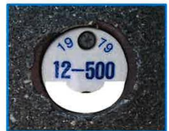
コンクリート柱の磁器製の銘板
